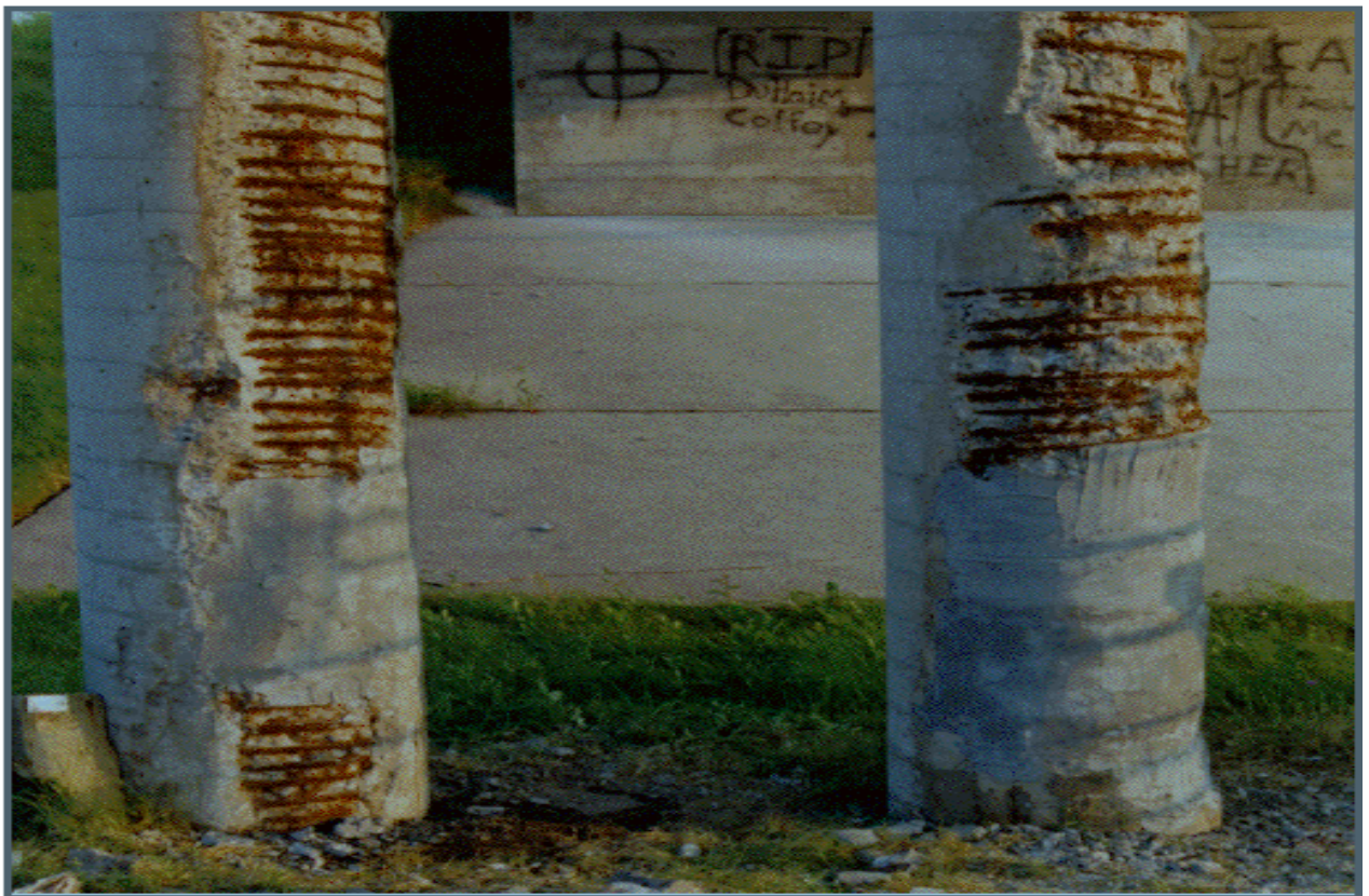
Figure I-1 : corrosion sévère des armatures d'acier dans ces poteaux de pont causant l'écaillage de l'enrobage de béton et l'exposition des barres d'armatures. [1]
