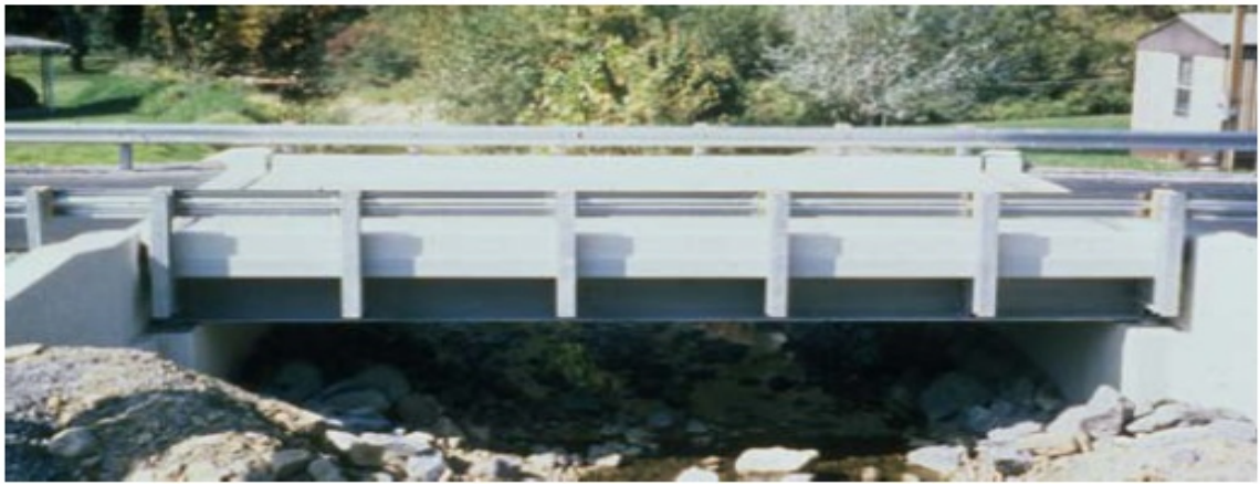
Figure I-6 : pont routier de petite portée entièrement fait de PRF
